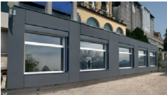
Schulungsräume einer Hotelfachschule mit vorgehängter Eternit-Fassade
