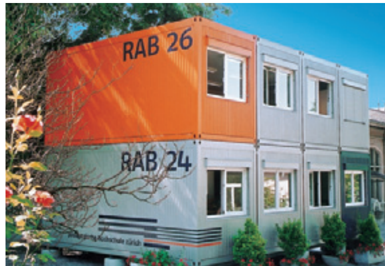
Schulräume einer pädagogischen Hochschule mit spezieller Farbgebung
