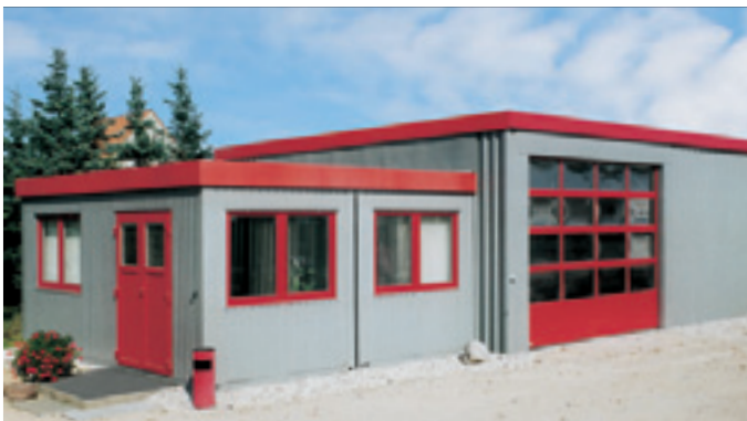
Kleinlagerhalle in Kombination mit Büroräumen
