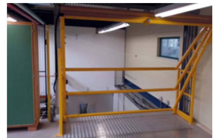
Lagerbühne mit Wippe und Sicherheitsschleuse
