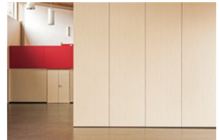
Keine Bodenführung, frei hängende Elemente, einzeln verfahrbar über Deckenlaufschiene aus Aluminium
