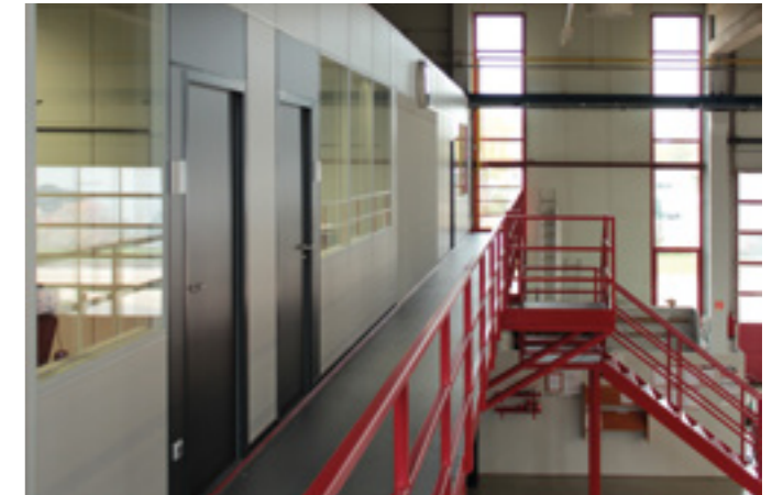
Stahlbaubühne mit Laufsteg
